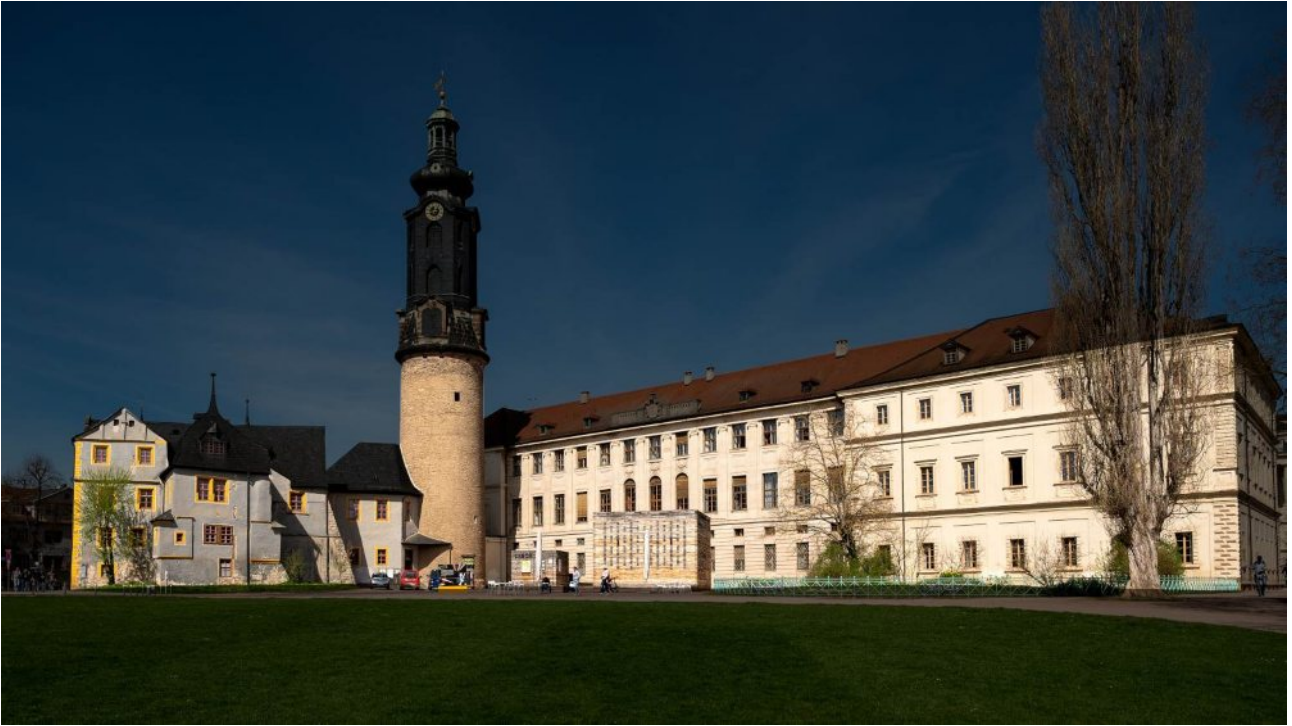
Die südliche Fassade des Stadtschloss Weimar und das Ensemble Bastille
